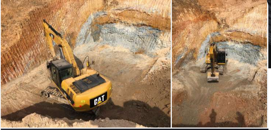
Foto 1. Condición inicial del proyecto
