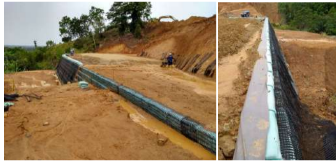
Foto 2-3 Colocación de sistema de subdrenaje en el espaldar del muro con geodrén Permadrain 70. Conformación de la cara del muro con bolsas Propybag, geotextil para separación y geomallas uniaxiales Fortgrid UX.
