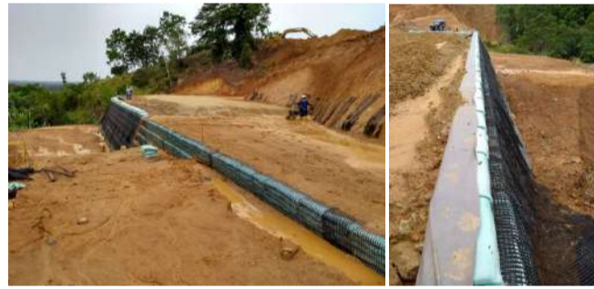
Foto 2-3 Colocación de sistema de subdrenaje en el espaldar del muro con geodrén Permadrain 70. Conformación de la cara del muro con bolsas Propybag, geotextil para separación y geomallas uniaxiales Fortgrid UX.
