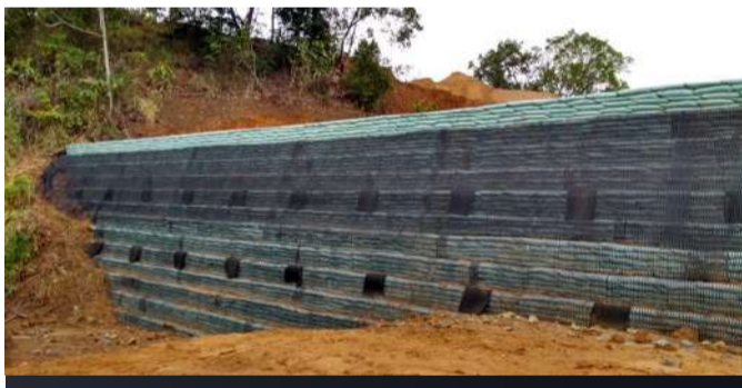
Foto 4. Sistema de subdrenes horizontales en geodrén Permadrain 70
