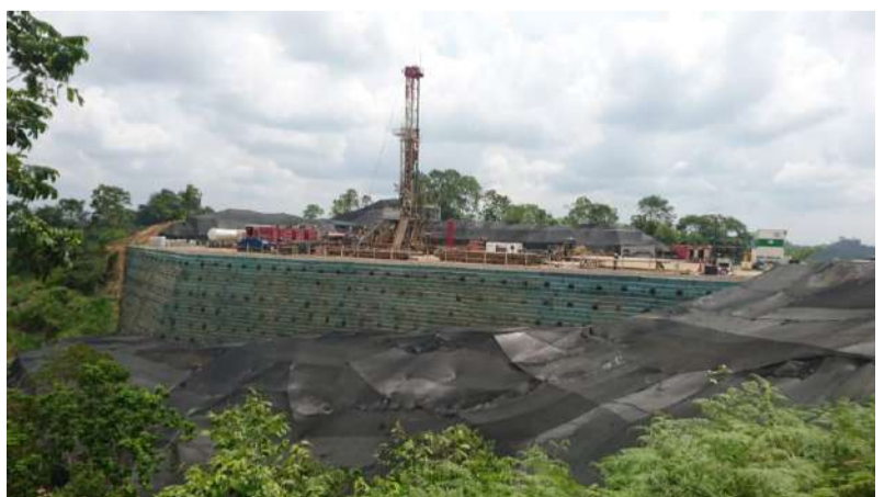
Foto 6. Condición al final de la construcción del proyecto.
