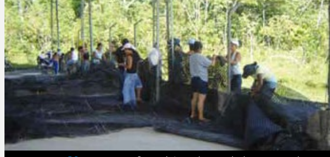
Fotografía 5. Confección de colchones de enrocado con hidromalla Geoestera.
