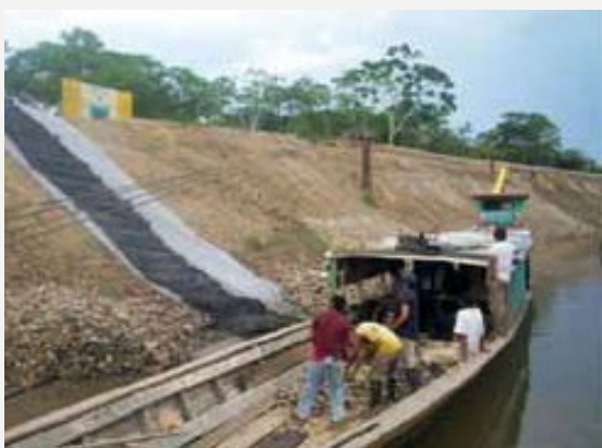
Fotografía 6. Filtro para controlar la pérdida de suelos finos.
