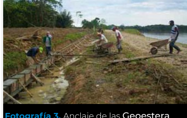
Fotografía 3. Anclaje de las Geoesteras
