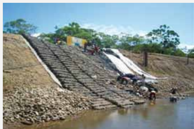
Fotografía 7. Filtro para controlar la pérdida de suelos finos.
