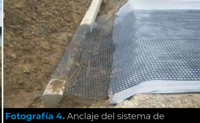
Fotografía 4. Anclaje del sistema de protección
