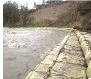
Estructuras de confinamiento. San Marcos - Perú.
