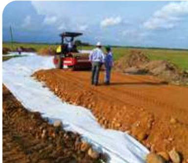
Refuerzo de subrasantes y capas granulares. Casanare - Colombia.
