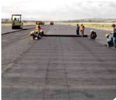
Refuerzo de carpeta asfáltica. Latacunga - Ecuador.
