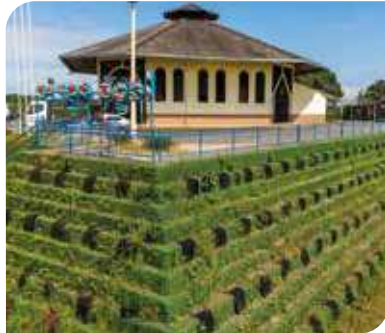
Muro de contención en suelo reforzado. Nueva Loja - Ecuador.
