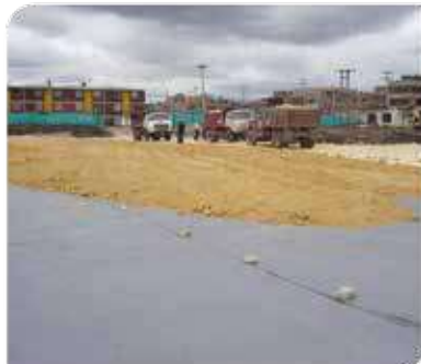
Separación y filtro en vías. Bogotá - Colombia.
