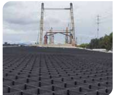
Refuerzo de capas granuales. Bogotá - Colombia.
