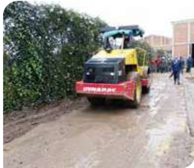
Soporte de pavimentos sobre suelos blandos. Bogotá - Colombia.
