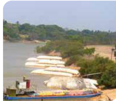
Estructuras de encauzamiento. Meta - Colombia.
