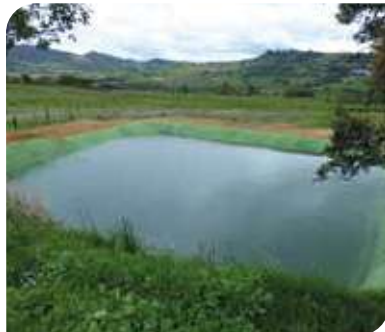
Revestimiento de lagos y reservorios. Cundinamarca- Colombia.
