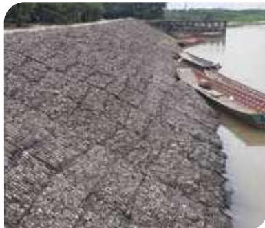
Protección en orillas. Arauca - Colombia.
