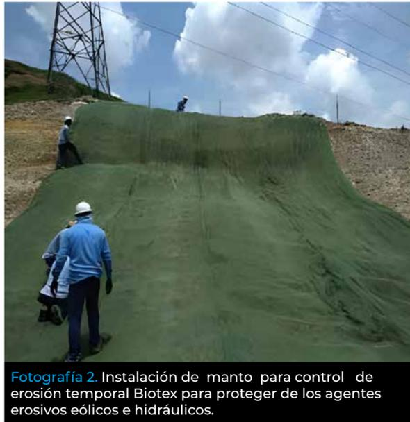
Fotografía 2. Instalación de manto para control de erosión temporal Biotex para proteger de los agentes erosivos eólicos e hidráulicos.
