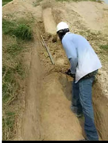
Fotografía 3. Excavación y perfilado del perímetro de la zanja de coronación.
