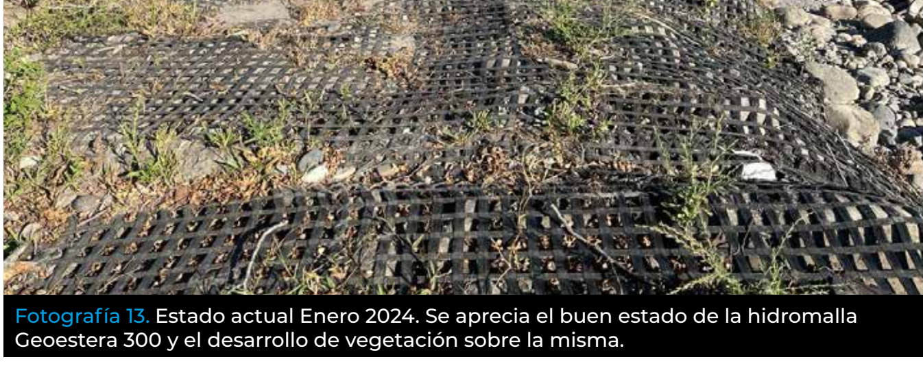
Fotografía 13. Estado actual Enero 2024. Se aprecia el buen estado de la hidromalla Geoestera 300 y el desarrollo de vegetación sobre la misma.
