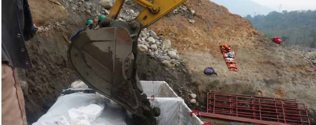
Fotografía 12. Plataforma conformada en módulos gavión en Hidromalla Geoestera 300 y módulos tipo colchón para control de socavación de la estructura, para la protección del paso subfluvial frente a las fuerzas tractivas del río Cravo Sur.
