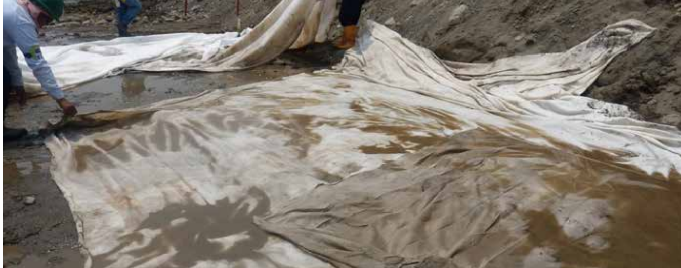
Fotografía 8. Instalación Geotextil de separación Fortex BX 760.
