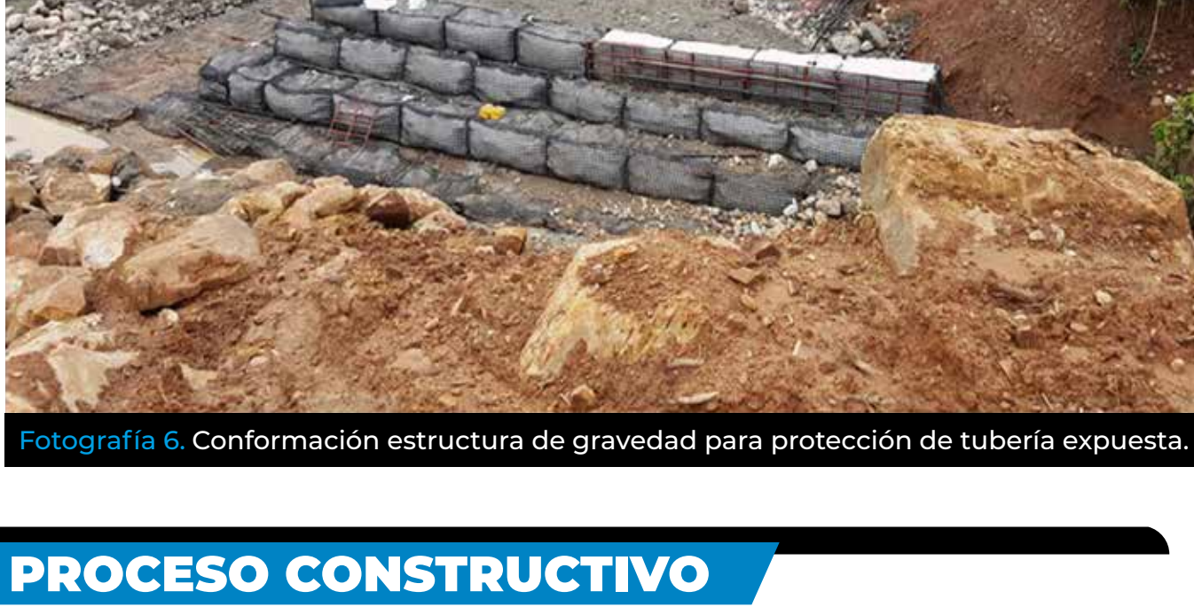
Fotografía 6. Conformación estructura de gravedad para protección de tubería expuesta.
