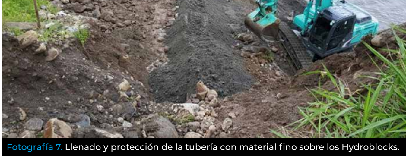
Fotografía 7. Llenado y protección de la tubería con material fino sobre los Hydroblocks.
