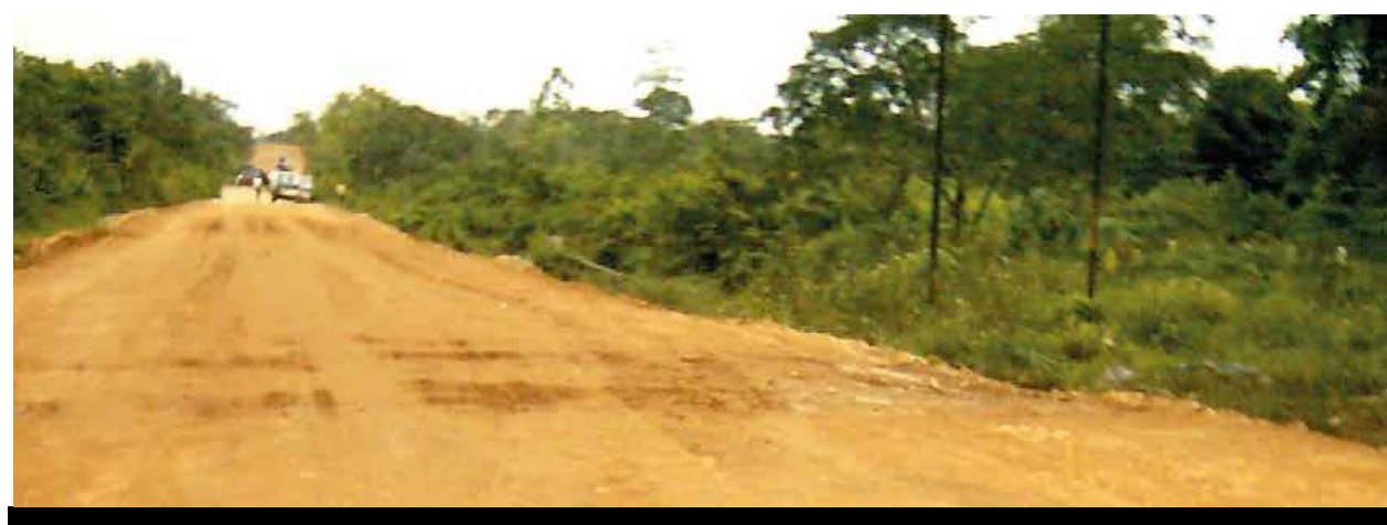
Fotografía 5. Condición al final de la construcción de la vía.
