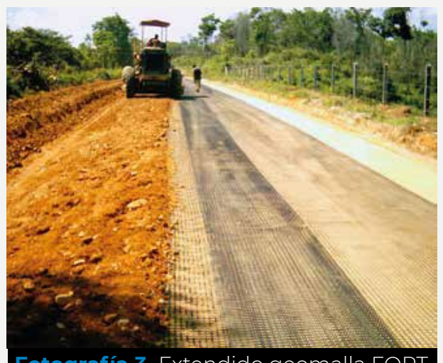
Fotografía 3. Extendido geomalla FORT-GRID® BX 50(35)
