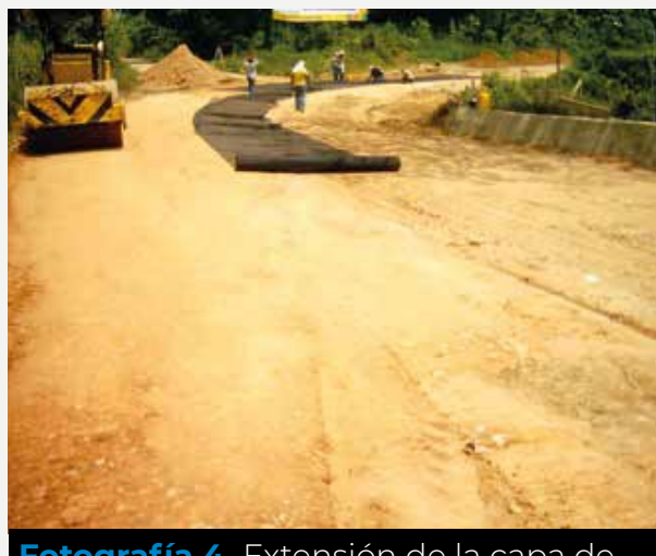
Fotografía 4. Extensión de la capa de base granular.
