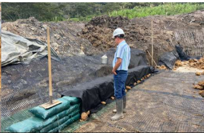
Fotografía 1. Extendido de la geomalla Fortgrid para la conformación de las capas del muro en suelo reforzado. Se aprecia también la colocación de saquillos llenos con suelo y el manto TERRATRAC TRM.
