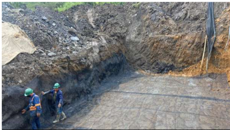
Fotografía 1. Extendido de la geomalla Fortgrid para la conformación de las capas del muro en suelo reforzado. Se aprecia también la colocación de saquillos llenos con suelo y el manto TERRATRAC TRM.
