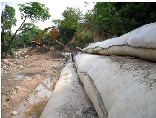
Fotografía 9. Tubos geotextiles para protección de orillas.
