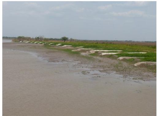
Fotografía 10. Espigones para encauzamiento conformados con tubos geotextil.
