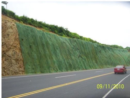
Fotografía 3. Control de caída de detritus con mantos permanentes para control de erosión.
