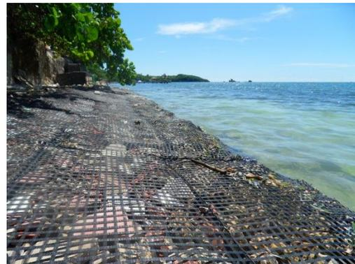
Fotografía 8. Protección de orillas costeras con colchones de enrocado confiando con geomallas de poliéster.
