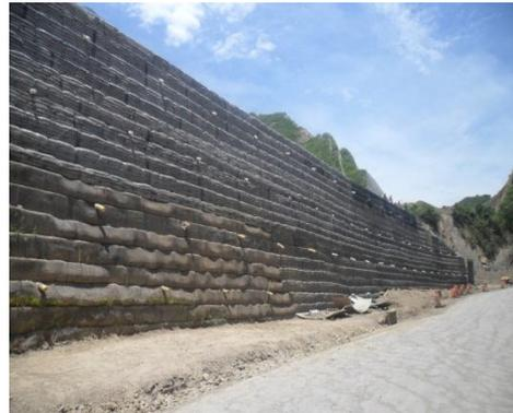
Fotografía 1. Estructura en suelo reforzado con geomallas.
