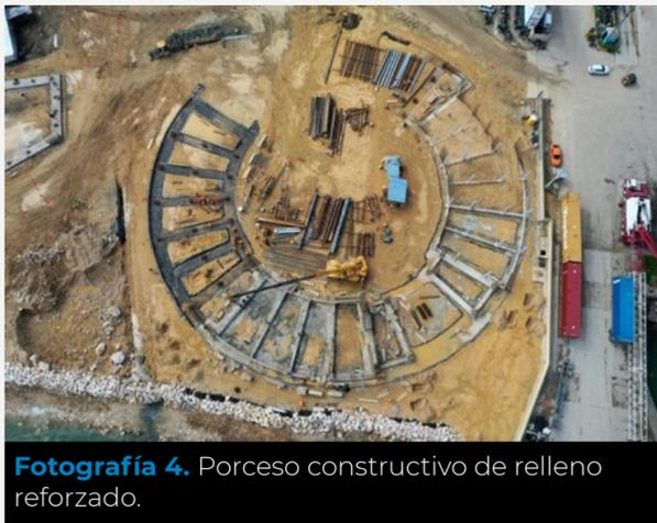
**Fotografía 4.** Porceso constructivo de relleno reforzado.
