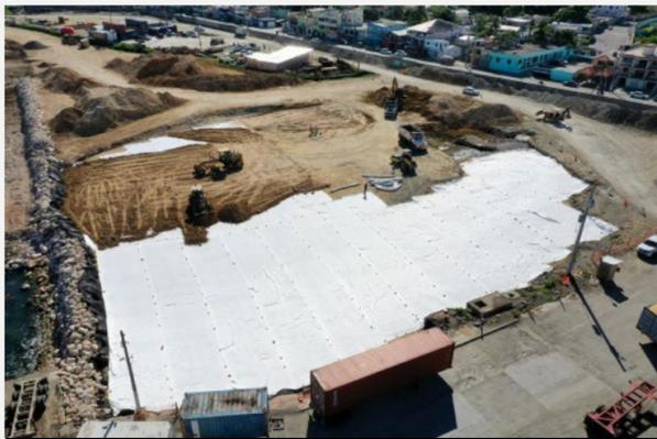
**Fotografía 3.** Extendido de capa granular sobre Fortex.
