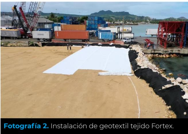
**Fotografía 2.** Instalación de geotextil tejido Fortex.
