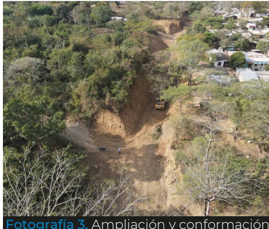
Fotografía 3. Ampliación y conformación de nuevas secciones.
