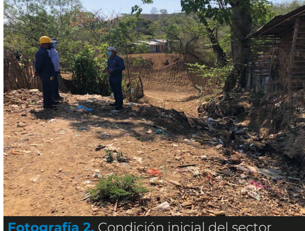
Fotografía 2. Condición inicial del sector.
