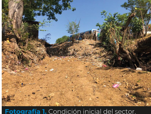
Fotografía 1. Condición inicial del sector.
