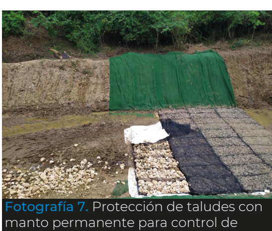
Fotografía 5. Instalación colchones de enrocado.
