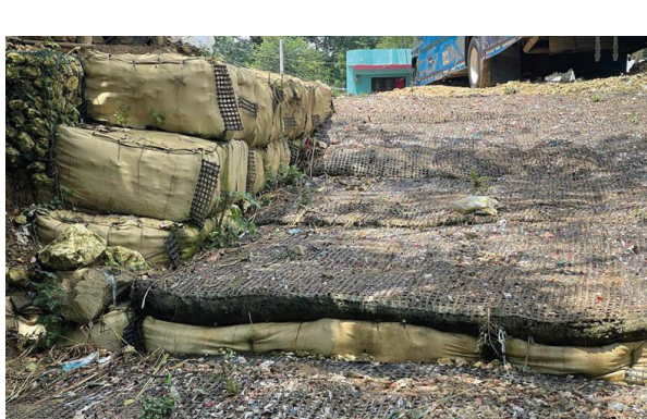
Fotografía 12. Realce de cárcavas y protección con HYDROBLOCK y colchones de enrocado en hidromalla GEOESTERA 50.
