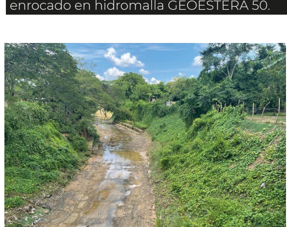
Fotografía 13. Panorámica de la estructura terminada.
