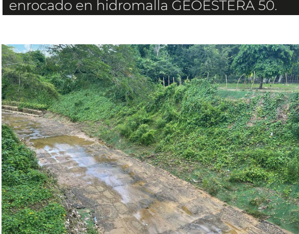
Fotografía 14. Panorámica de la estructura terminada.
