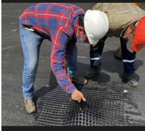
Fotografía 2. Ejecución de la prueba de adherencia.
