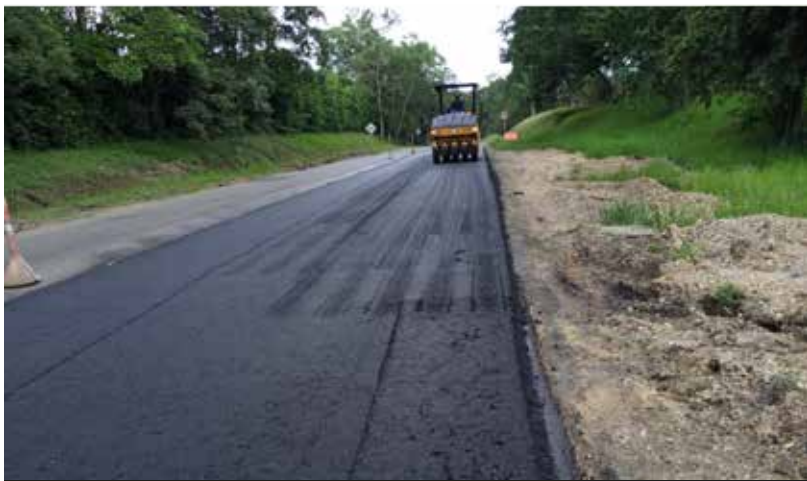
Fotografía 5. Compactación de la capa asfáltica sobre la geomalla.
