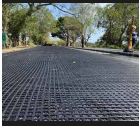
Fotografía 3. Extendido de la geomalla sobre la superficie impregnada con asfalto.
