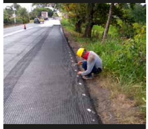
Fotografía 4. Fijación de la geomalla en los bordes de la vía.
