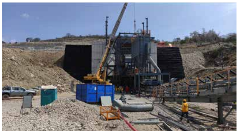
Fotografía 1. Vista general de la estructura de acceso a la planta trituradora de agregados
