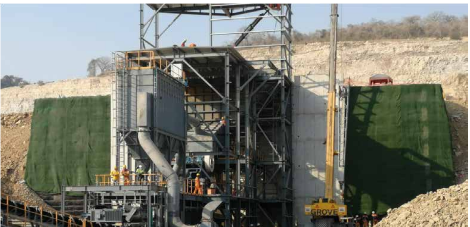
Fotografía 6. Panorámica de la estructura terminada
