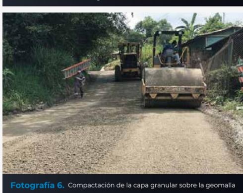
Fotografía 6. Compactación de la capa granular sobre la geomalla
