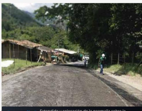
Fotografía 3. Extendido y colocación de la geomalla sobre la subrasante
