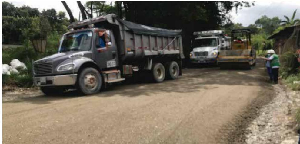
Fotografía 3. Capa granular terminada
