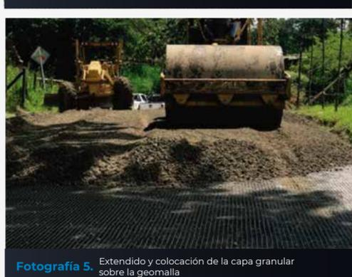
Fotografía 5. Extendido y colocación de la capa granular sobre la geomalla
