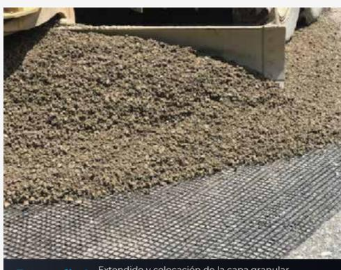
Fotografía 4. Extendido y colocación de la capa granular sobre la geomalla
