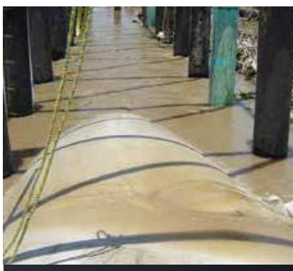
Fotografías 1 y 2. Uso de HYDROTUBES para conformación de núcleo de espigones
