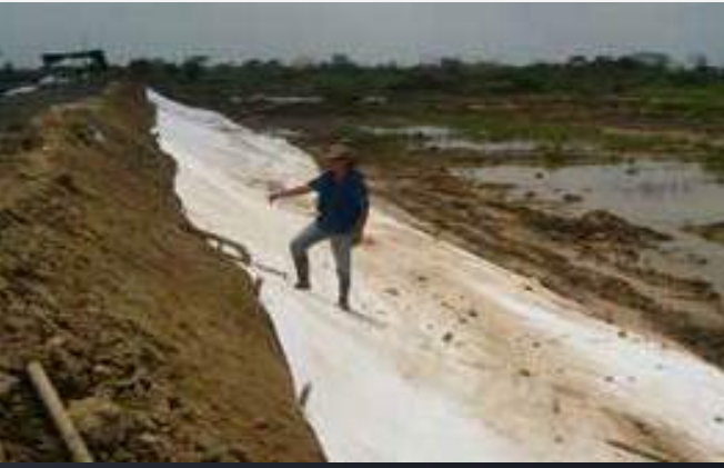
Fotografías 7 y 8 Mantos antisocavación con geotextiles FORTEX
