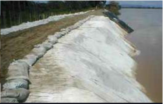
Fotografías 5 y 6 Control de erosión en cara húmeda de diques con TERRATRAC TRM 50
