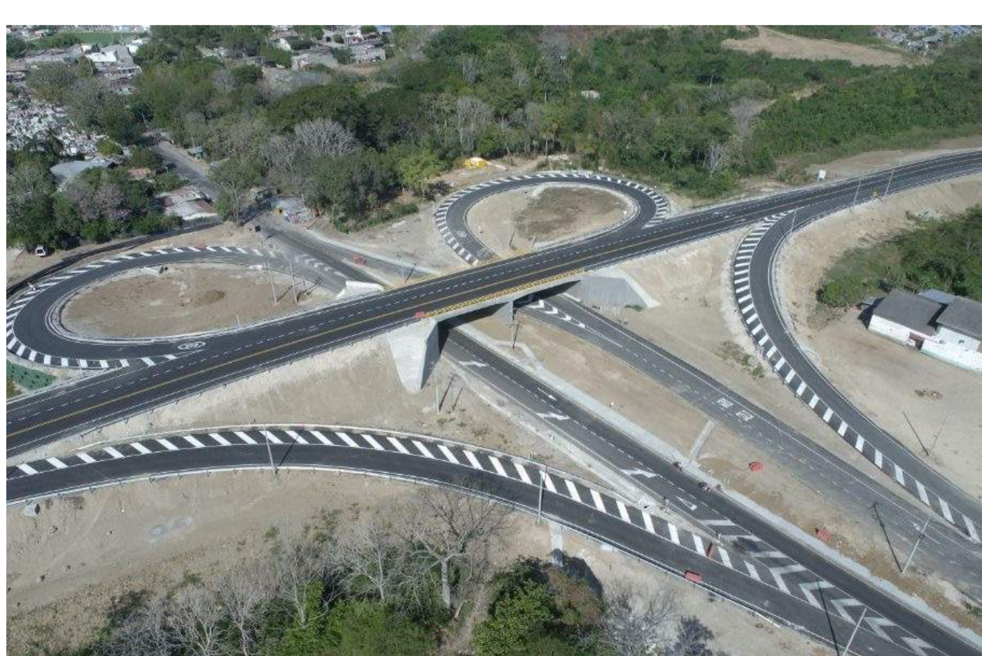
Fotografía 7. Obra terminada. La estructura en suelo reforzado permite dar desarrollo geométrico para el paso elevado sobre la carretera antigua, conectando el tránsito entre las dos vías
