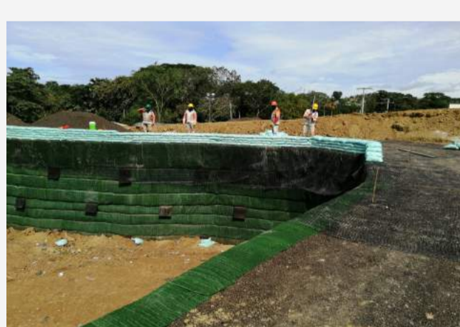
Fotografía 4. Proceso constructivo. Instalación de geomallas, elementos de fachada y de subdrenaje
