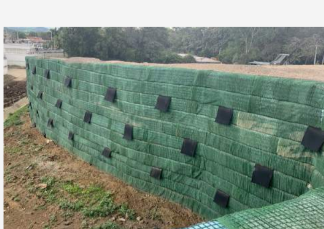
Fotografía 6. Vista del muro parcialmente terminado. Se aprecian subdrenes horizontales y fachada con manto para control de erosión
