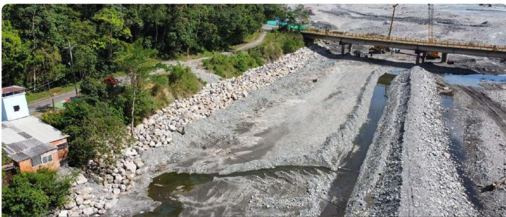
Fotografía 7. Disposición de enrocado de gran tamaño D50 =1,3m desde aguas arriba del puente principal.
