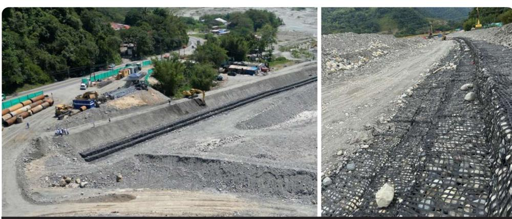
Fotografía 5 y 6. Conformación y disposición de Gaviones en la base del dique en Hidromalla Geoestera 80.
