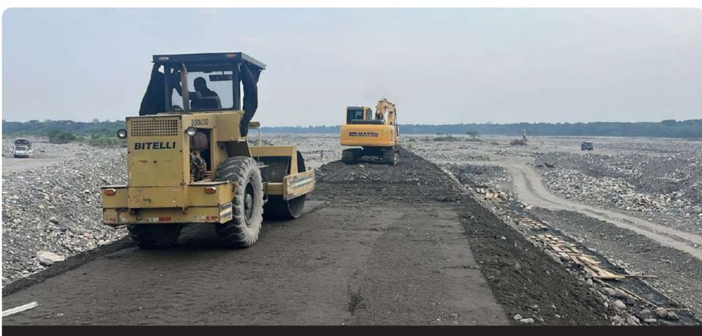
Fotografía 4. Conformación y compactación del dique de 3,0 m de altura.
