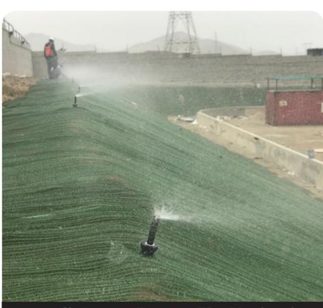
Fotografía 7. Manto Terratrak TRM 50 colocado sobre el terreno
