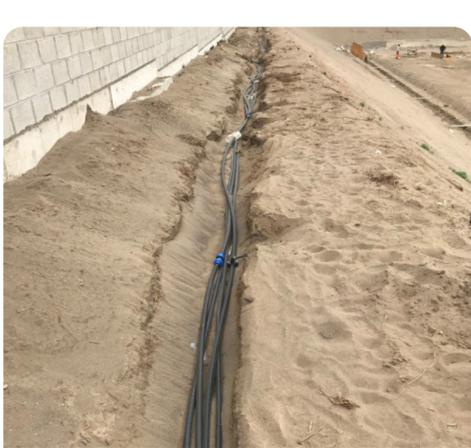
Fotografía 5. Colocación de tuberías para sistemas para riego por aspersión
