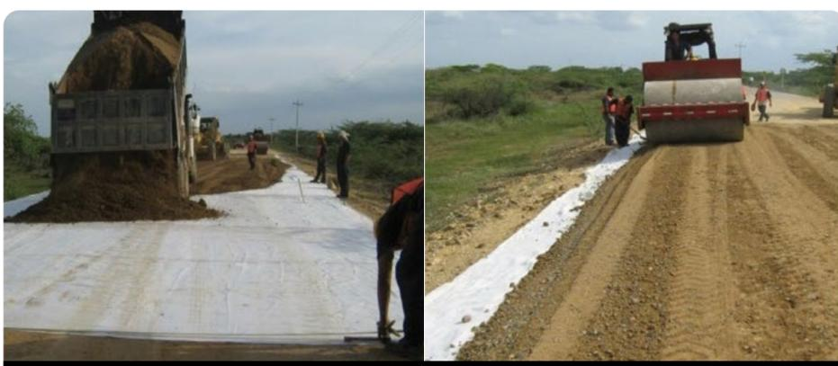
Fotografía 3 y 4. Instalación del geotextil y extensión del material granular del terraplén.
