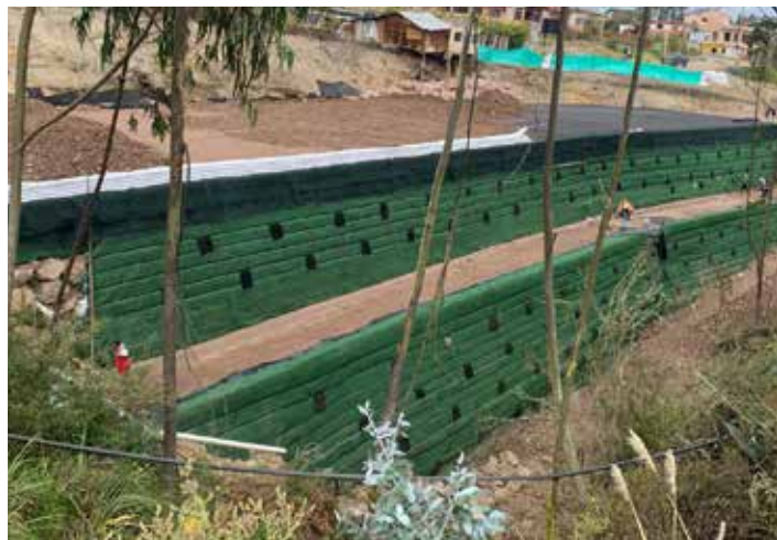
Fotografía 9. Colocación y compactación del suelo de conformación sobre la geomalla en la parte superior de la estructura
