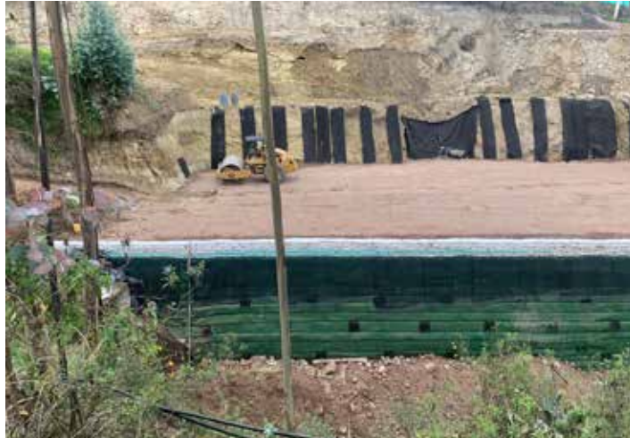
Fotografía 7. Colocación y compactación del suelo de conformación sobre la geomalla
