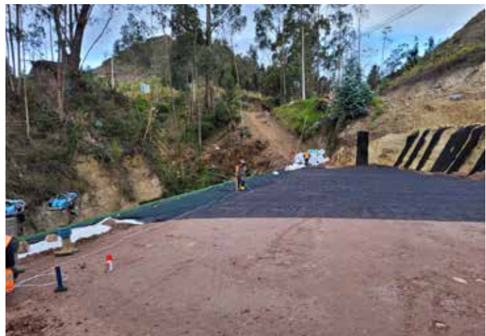
Fotografía 6. Colocación de las capas de geomalla para refuerzo del suelo de conformación
