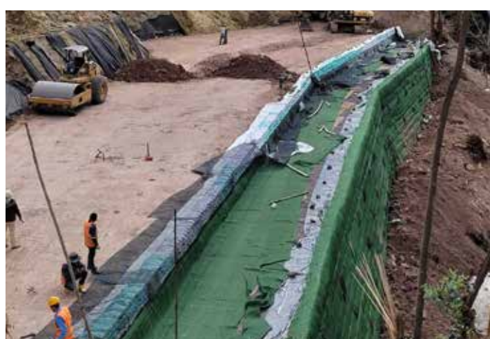
Fotografía 8. Berma intermedia que favorece la estabilidad de la estructura. Se observa el revestimiento de la cara con manto TERRATRAC TRM 50
