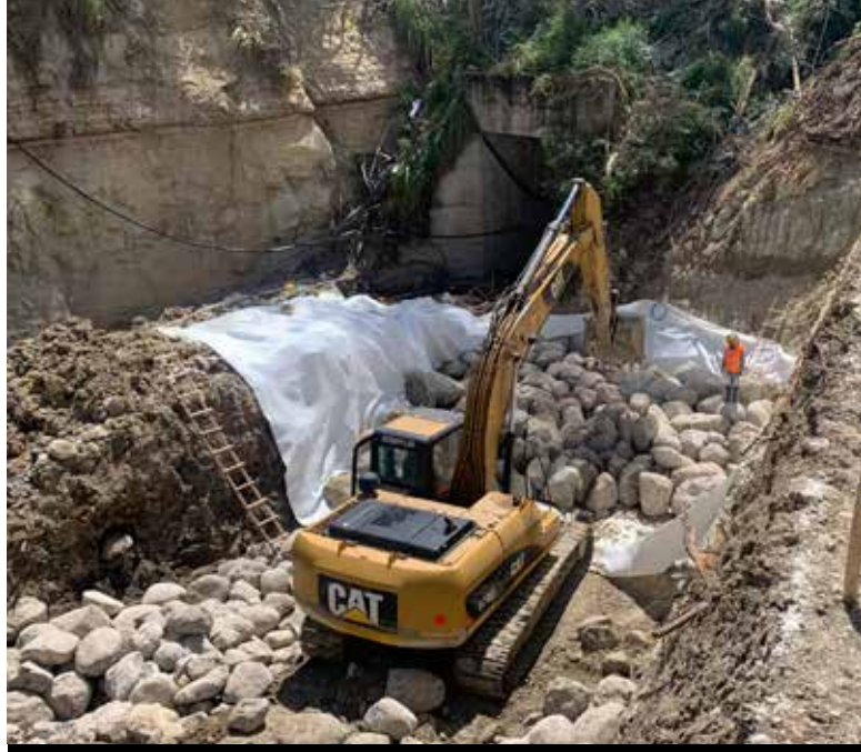
Fotografía 4. Lecho drenante con FORTEX
