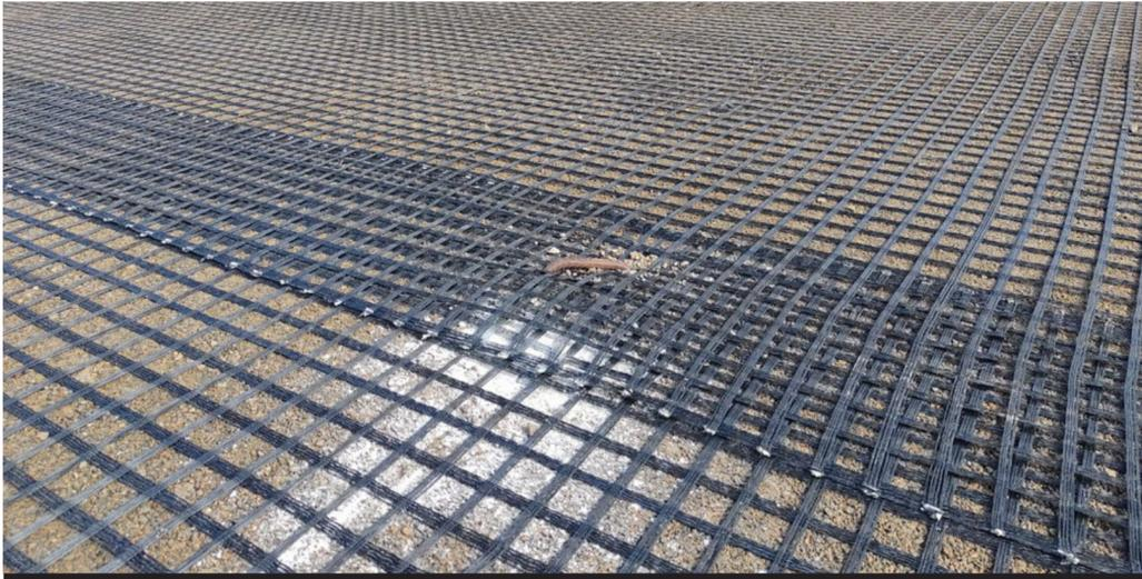
Fotografía 2. Anclajes en zona de traslape.
