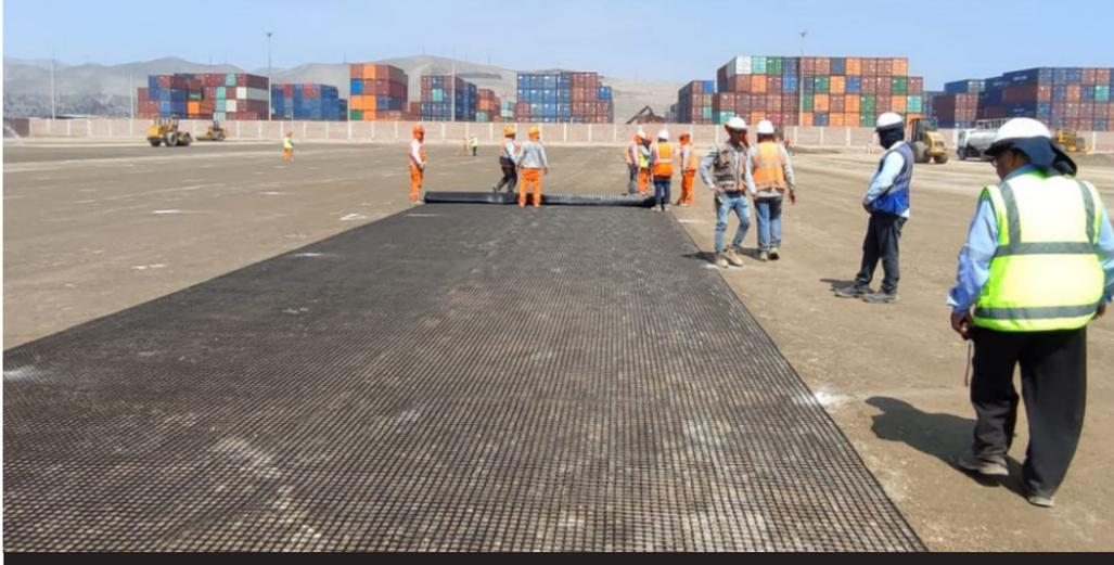
Fotografía 1. Instalación de la geomalla FORTGRID BX 30 sobre la capa de subbase granular.
