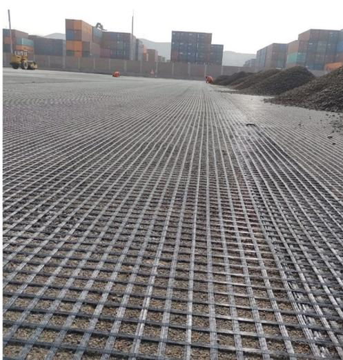
Fotografía 3. Vista de la instalación de la geomalla antes del extendido del material granular.
