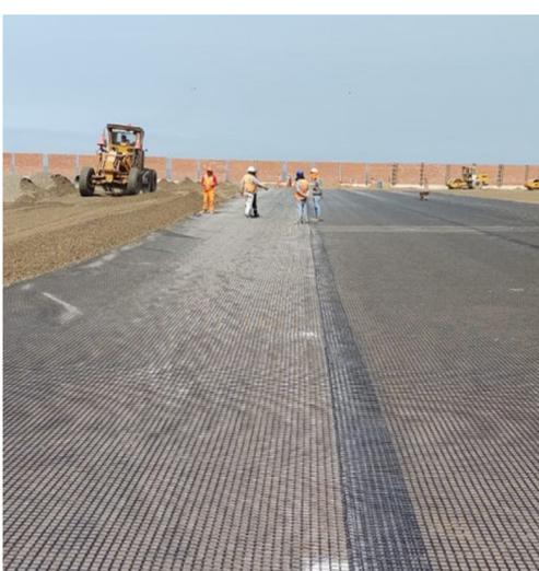
Fotografía 4. Extendido y compactación del material base granular sobre la geomalla FORTGRID BX 30.
