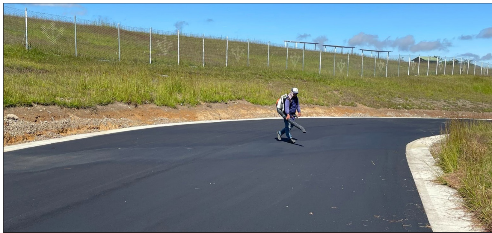
Fotografía 1. Limpieza de la superficie
