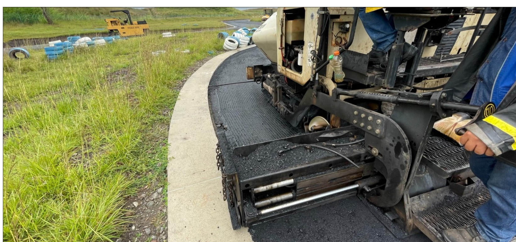
Fotografía 4. Colocación de la rodadura asfáltica
