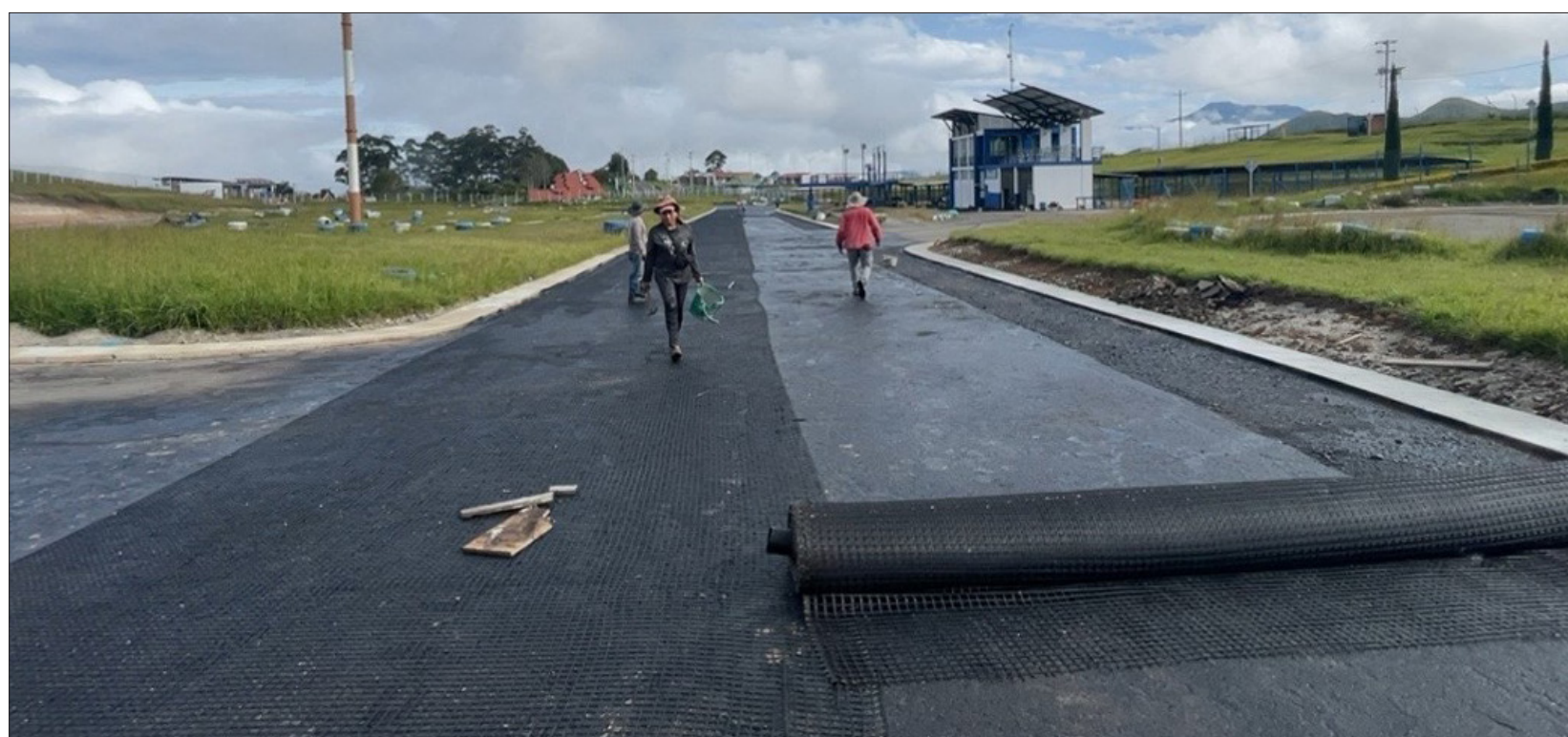
Fotografía 2. Instalación de la geomalla
