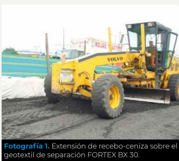
Fotografía 1. Extensión de recebo-ceniza sobre el geotextil de separación FORTEX BX 30.
