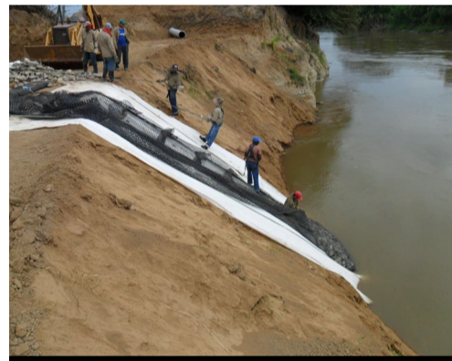
Fotografía 4. Llenado de Geoestera con enrocado
