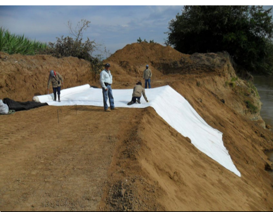
Fotografía 2. Despliegue del geotextil Fortex para control de erosión sobre el suelo del dique.
