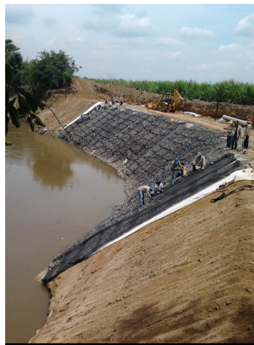
Fotografía 3. Instalación de Geoestera sobre el talud.
