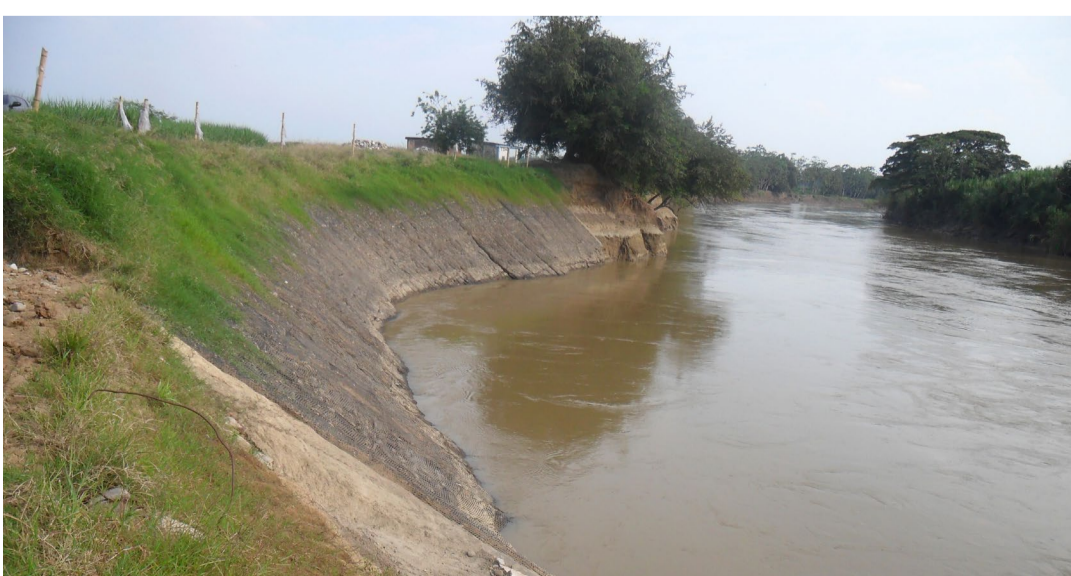
Figura 4. Vista de la orilla luego de terminar el proyecto.
