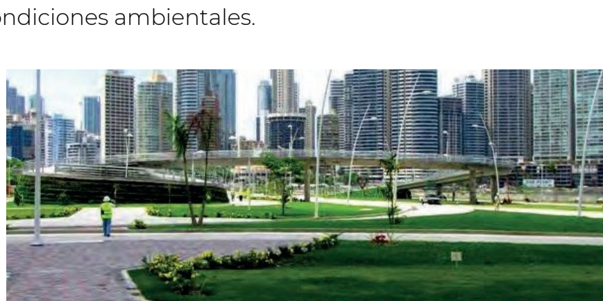
Fotografía 8. Condición final del proyecto.
