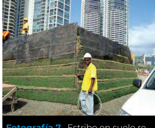
Fotografía 7. Estribo en suelo reforzado con fachada vegetalizada.
