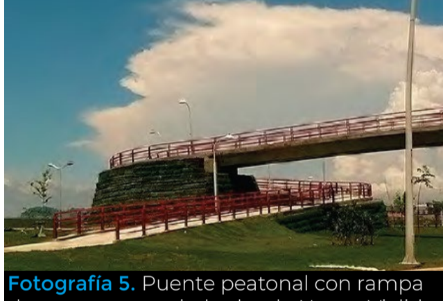
Fotografía 5. Puente peatonal con rampa de acceso en espiral sobre la Nueva Vialidad en servicio.
