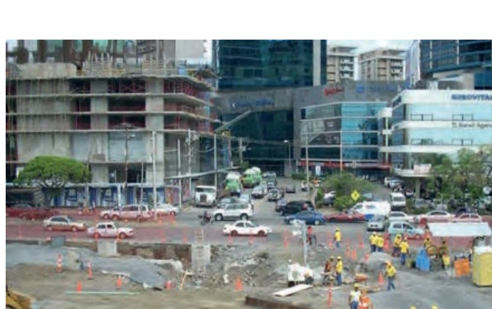
Fotografía 6. Construcción del estribo del puente peatonal en suelo reforzado con geomallas FORTGRID
