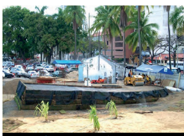
Fotografía 4. Rampa de puente peatonal en suelo reforzado con geomallas FORTGRID.
