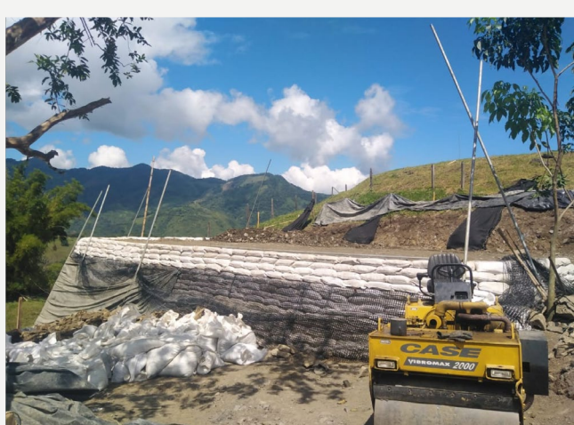
Fotografía 2. Conformación de capas del muro en suelo reforzado con geomallas uniaxiales FORTGRID UX
