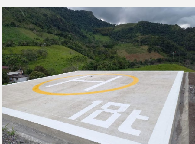
Fotografía 4. Estructura de pavimento colocada sobre el muro en suelo reforzado
