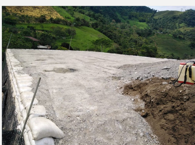
Fotografía 3. Proceso de extendido de material y compactación de las capas del muro en suelo reforzado
