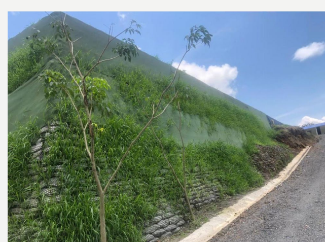
Fotografía 5. Etapa final de la construcción del Helipuerto
