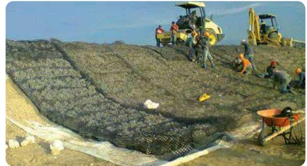
Protección a la socavación del lecho en aproximaciones a puentes y en zonas estribos.
