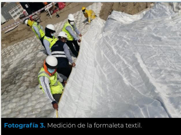
**Fotografía 3.** Medición de la formaleta textil.
