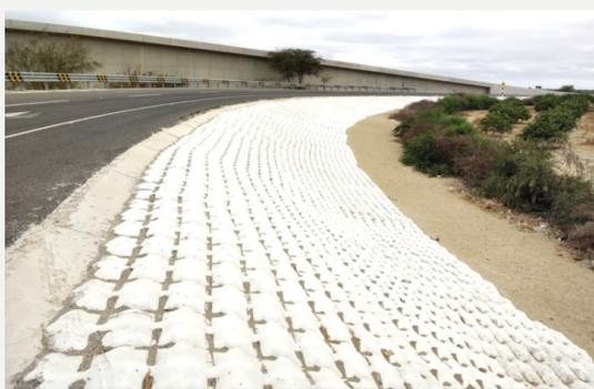
**Fotografía 1.** Protección contra la erosión en concreto utilizando la formaleta textil Colchacreto Articulado
