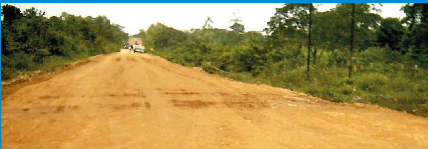
Foto 4. Condición al final de la construcción de la vía.
