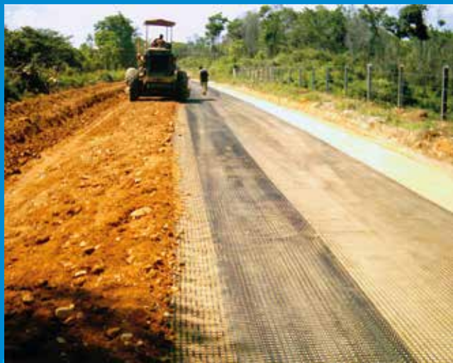
Foto 2. Extendido geomalla FORTGRID® BX 50(35).
