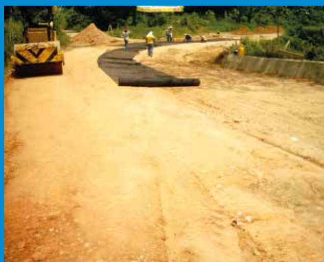
Foto 3. Extensión de la capa de base granular.
