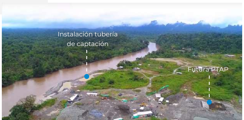
Foto 5. Condición al final de la construcción del proyecto.
