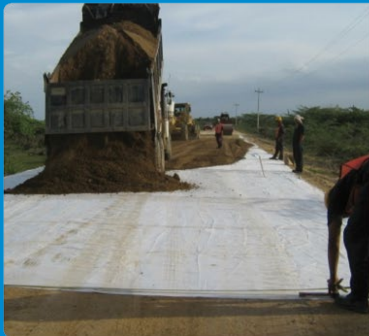
Fotografías 3 y 4. Instalación del geotextil y extensión del material granular del terraplén.
