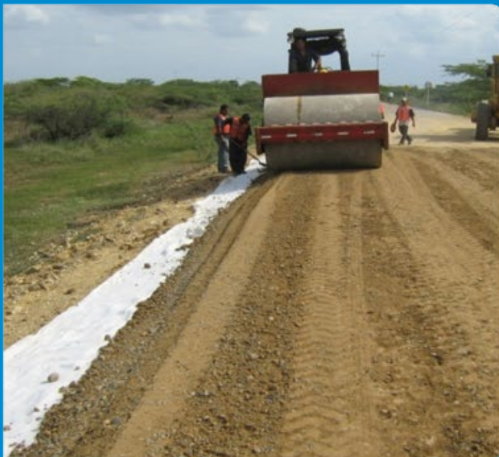
Fotografías 3 y 4. Instalación del geotextil y extensión del material granular del terraplén.
