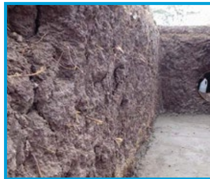
Fotografía 1 y 2. Material constituyente del terraplén existente (ver presencia de grietas y raíces).
