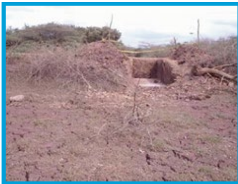
Fotografía 1 y 2. Material constituyente del terraplén existente (ver presencia de grietas y raíces).
