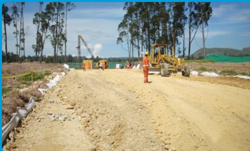
Foto 3. Construcción de terraplen de aproximación.
