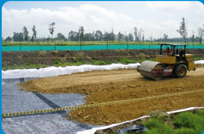
Foto 2. Instalación de Geosintéticos (ALO)
