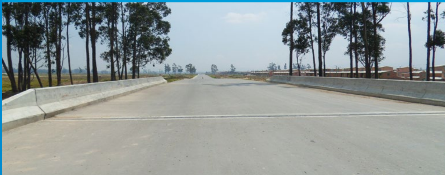
Foto 4. Terraplen de aproximación (ALO).
