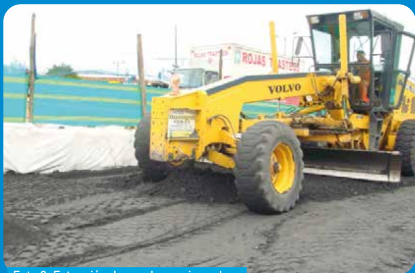
Foto 3. Extensión de recebo-ceniza sobre el geotextil de separación FORTEX® BX30.
