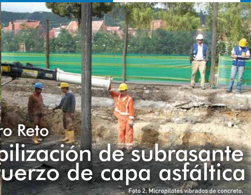
Foto 2. Micropilotes vibrados de concreto.
