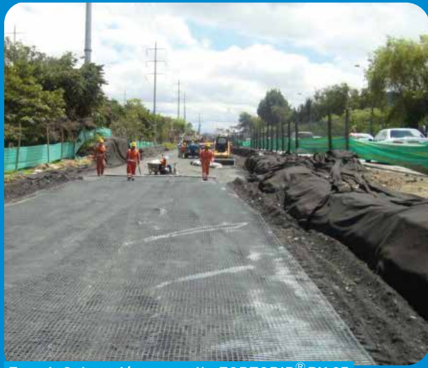
Foto 4. Colocación geomalla FORTGRID® BX 25.
