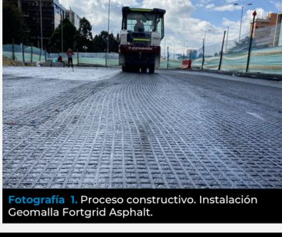
Fotografía 1. Proceso constructivo. Instalación Geomalla Fortgrid Asphalt.
