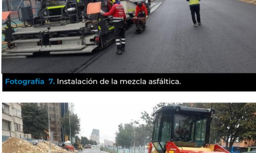
Fotografía 8. Compactación de la mezcla asfáltica.
