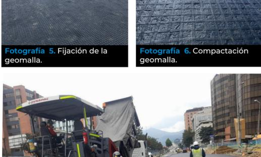
Fotografía 7. Instalación de la mezcla asfáltica.
