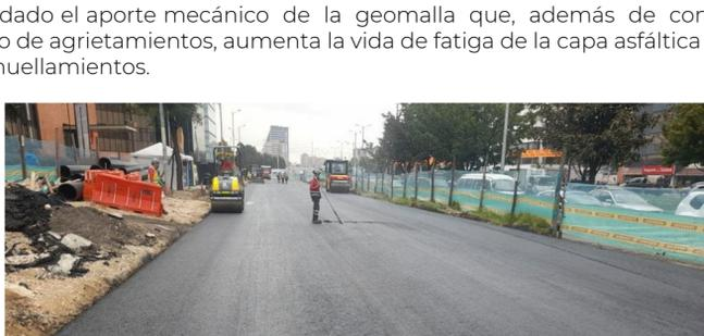
Fotografía 9. Resultado del reforzamiento de capa asfáltica.
